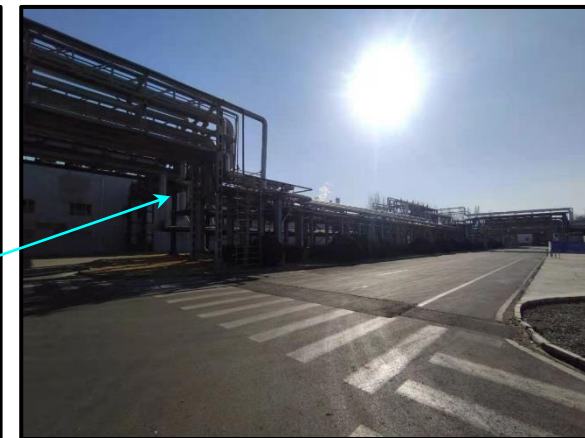
东侧为东十二号路及3万吨/年异戊橡胶装置变电所及机柜间
