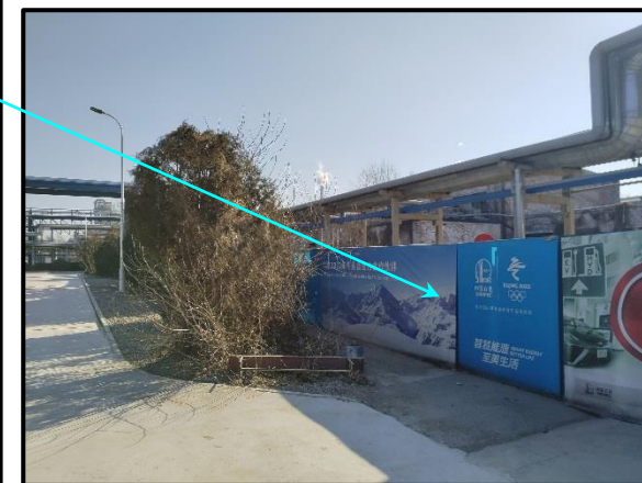
南侧为预留氢气液化单元（目前为冷却站房屋）
