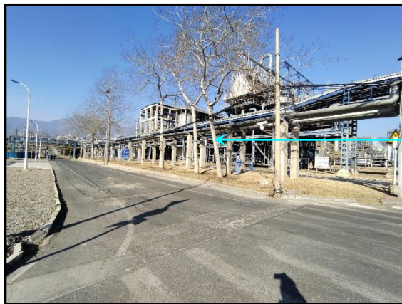
北侧为东九号路及3万吨/年异戊橡胶装置
