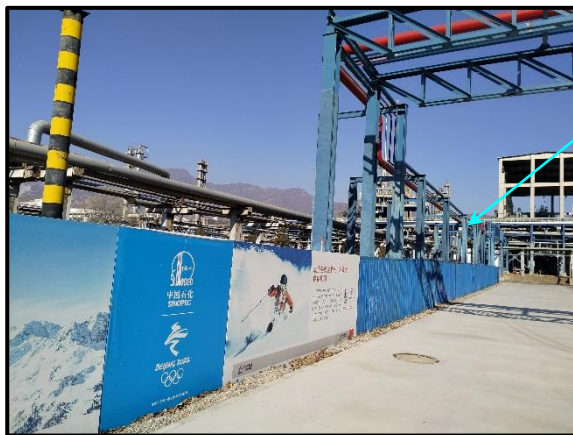
西侧为预留氢气纯化单元二期及空地
