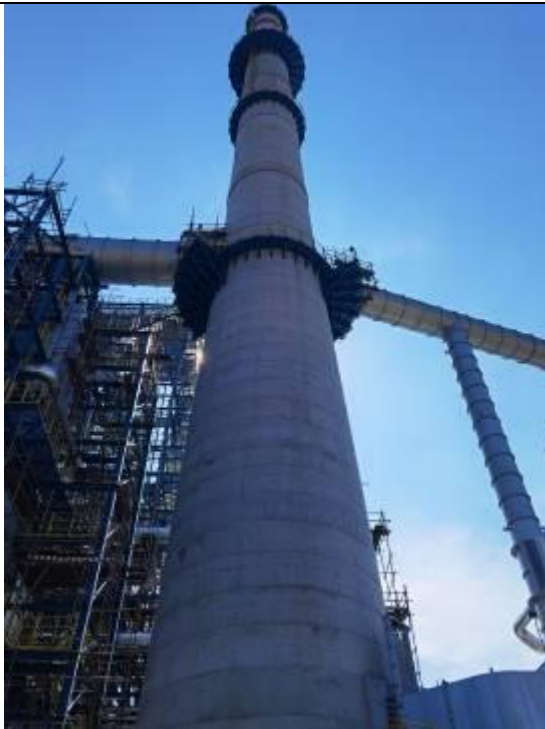
加热炉排气筒照片（100m）
