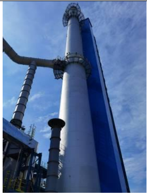
加热炉排气筒照片（70m）
